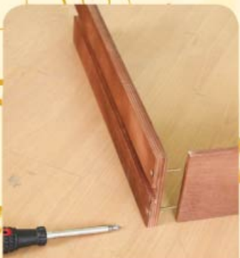
7. Соединить заднюю и боковые стенки ящика
