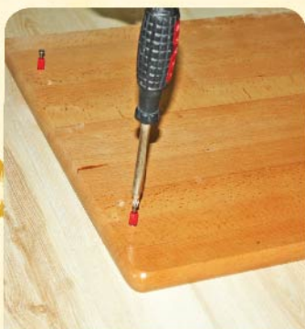
8. Вкрутить винт эксцентрика в столешницу
