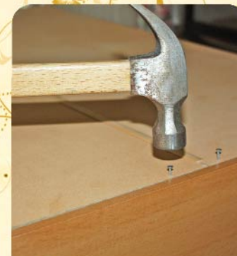
12. Установить соединительную рейку и зафиксировать вторую часть задней стенки гвоздями
