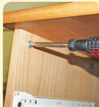
10. Зафиксировать эксцентриком
