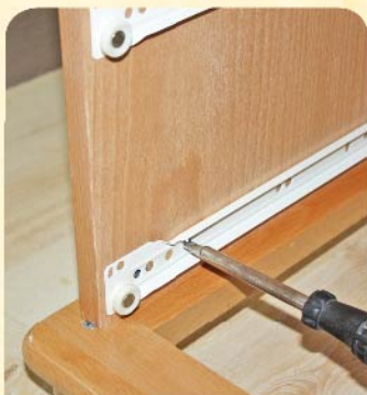
5. Закрепить роликовые направляющие на боках саморезом 4x16
